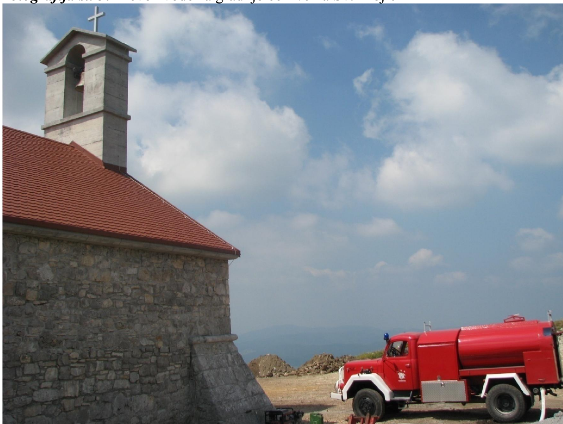
Fotografija št. 3: Prevoz vode za gradnjo cerkve na Sv. Trojici
