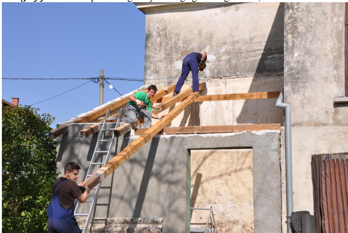
Fotografija št. 10: Priprave na gradnjo novega gasilskega doma, 2015
